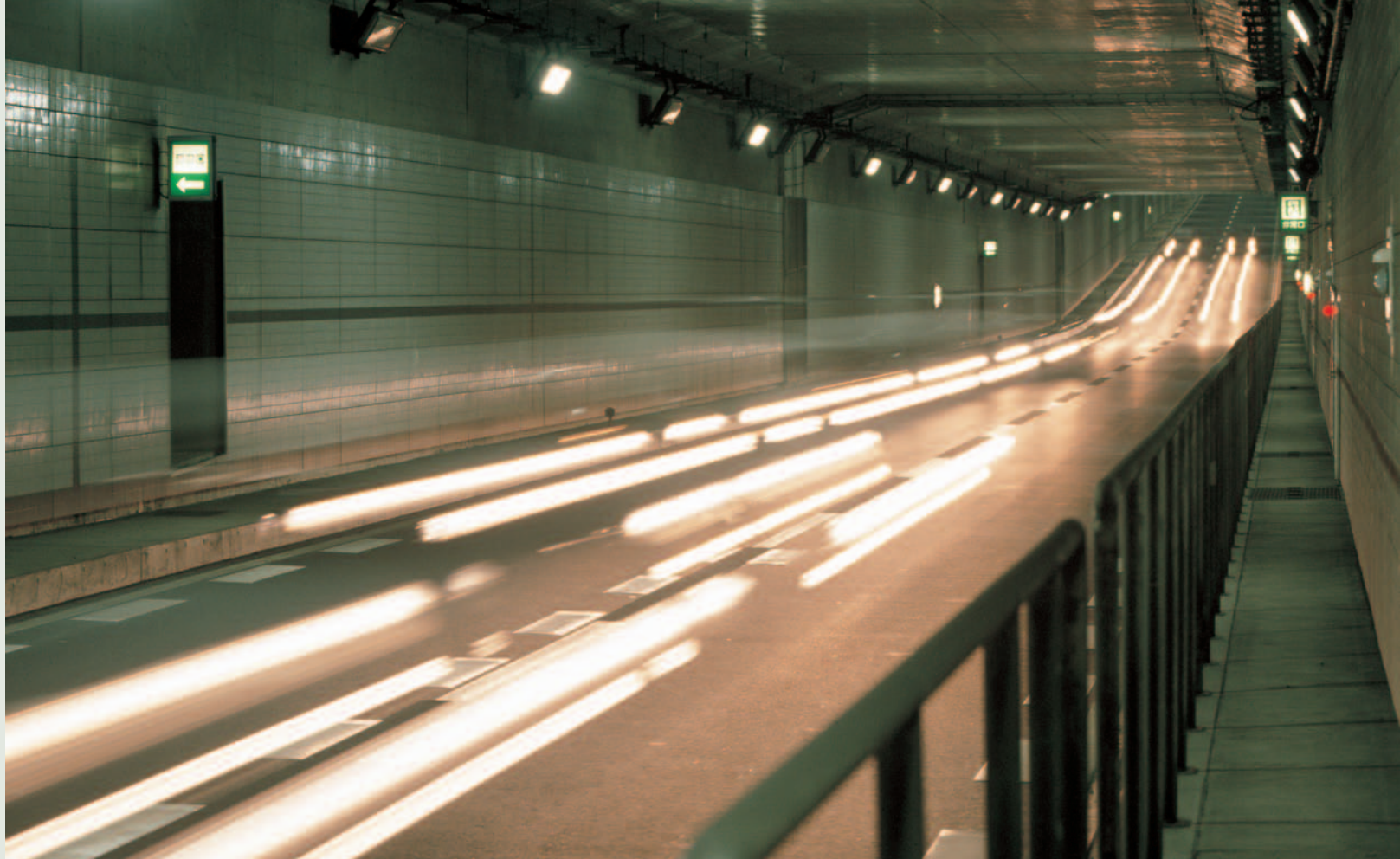
沈埋トンネルの内部。
