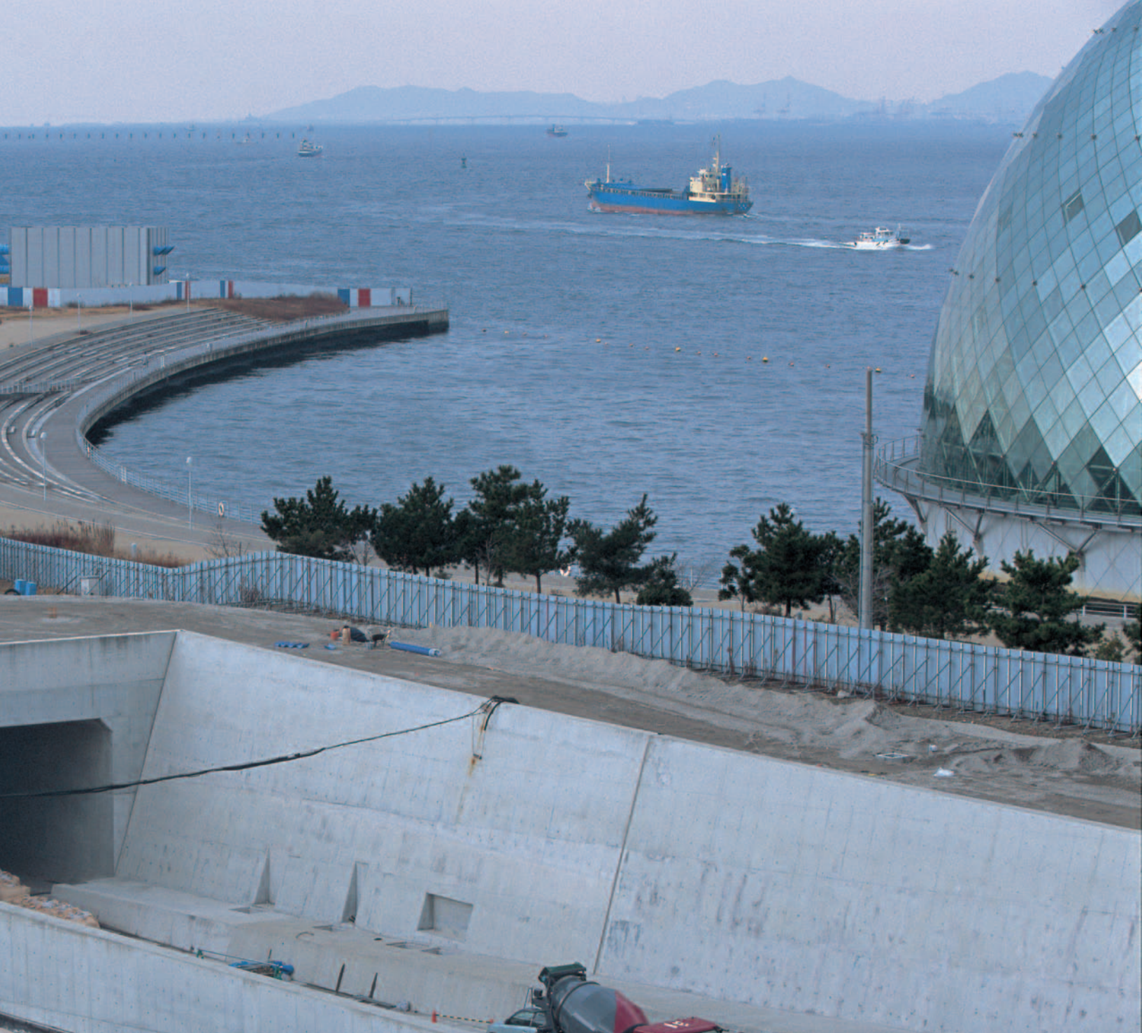
大阪港のシンボル、なにわの海の時空館のガラスドームのすぐ脇で建設が進む咲洲側アプローチ。
