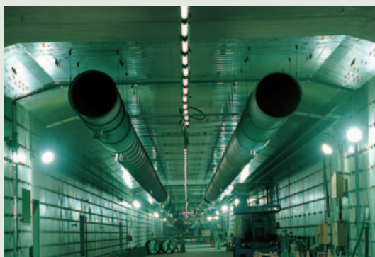
あらかじめ車両や鉄道などの通路が確保されている沈埋函。海底に沈め、接合したあとで仕上げの工事が行われる。
