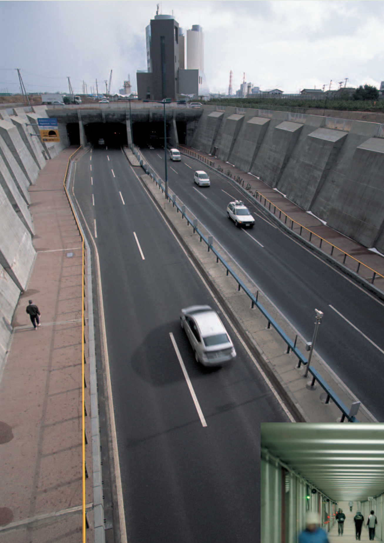
沈埋工法で造られた新潟みなとトンネルの入り口。左側に歩行車道が整備されている。
