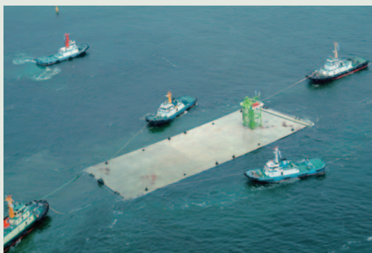
陸上のドックで作られた沈埋函は船で牽かれて所定の位置まで運ばれる。写真提供／国交省近畿地方整備局大阪港湾・空港整備事務所
